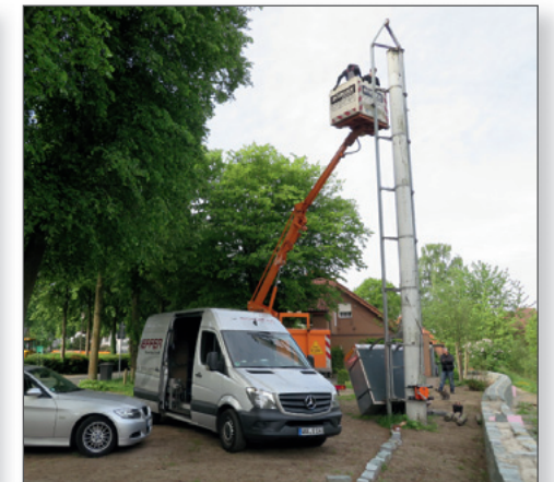
Der Hochstand bekommt eine neue Seilzuganlage
